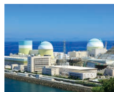
原子力発電所
